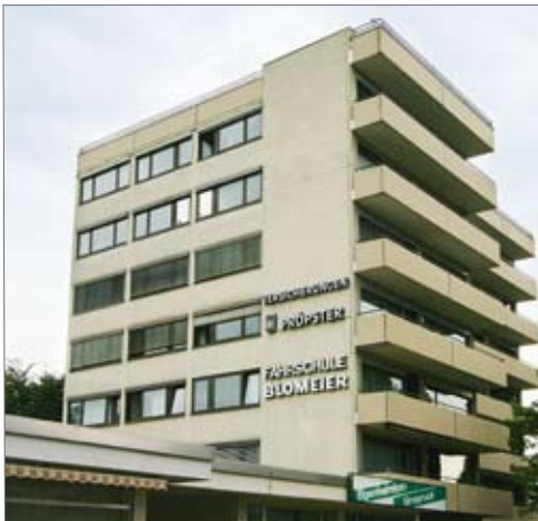
Referenzobjekt Neumarkt vor der Sanierung ...
