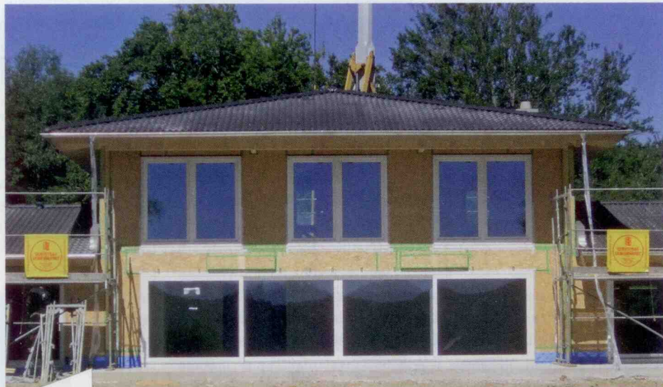
Bei der Realisierung einer fast zehn Meter breiten Hebe-Schiebe-Tür in einem gehobenen Einfamilienhaus unterzog die Höhbauer GmbH Planus einem ersten Einsatztest.
