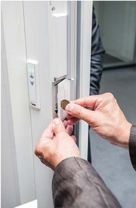
Mit einer Münze lässt sich der Filter leicht wechseln.
